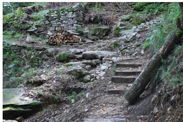
attraversamento riale in corso
