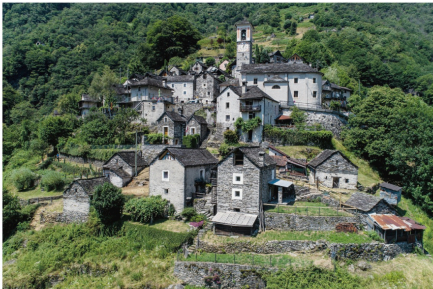
La commune de Corippo, au Tessin, veut transformer une partie de son centre historique en hôtel «diffus». KEYSTONE
