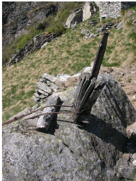
Ancoraggio di un filo a sbalzo
