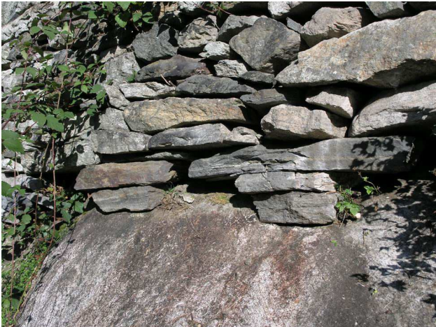
Tecnica di appoggio del muro a secco su una roccia affiorante
